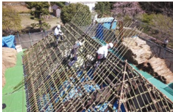
②屋練り (屋根の骨組み作り)
