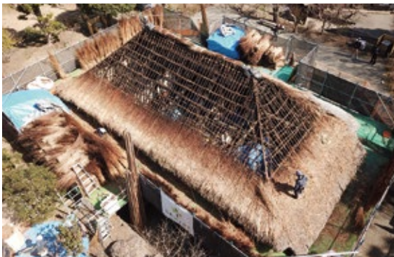
①茅こぼし (古い茅の撤去) 茅の下の骨組みは、イロリとカマドから出た煤(すす)で真っ黒になっていました。
