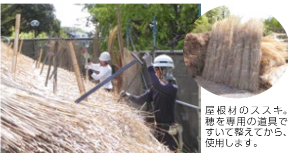
③茅葺き 茅は屋根に使われている植物の総称で、大和市ではススキが多く使われていました。今回使用したのは静岡県御殿場市のススキです。この作業中の4月24日には見学会を開きました。見学会では参加者が職人に質問したり熱心に話を聞いたりしていました。
