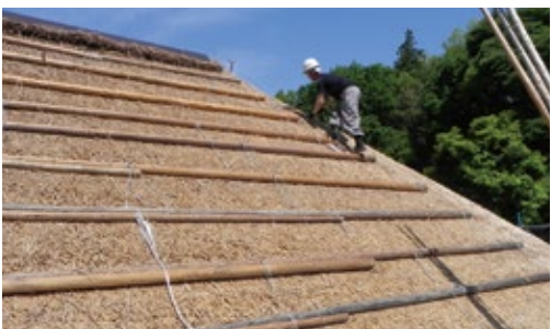
④刈り込み 専用のハサミを使って屋根の表面を整える作業です。
